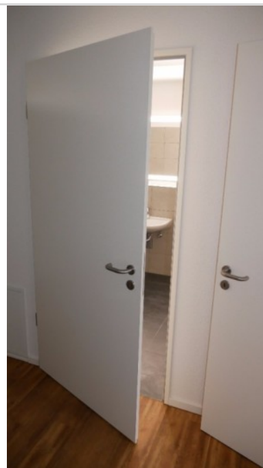
Breite Türen nach außen öffnen
